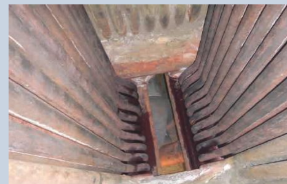
加热器管系更换工程
