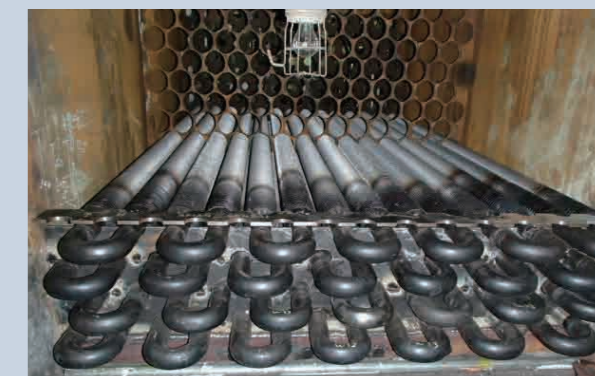
经济器管系更换工程
