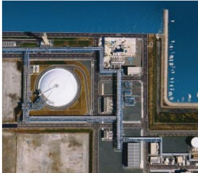
LNG In-ground Storage Tank
