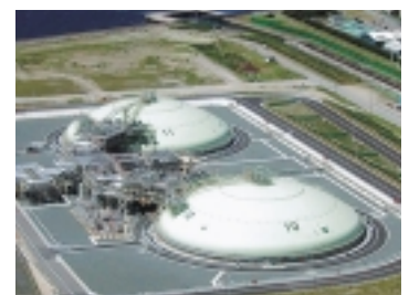
LNG In-ground Storage Tank
