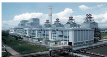
発電プラント
