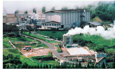
地熱発電プラント
