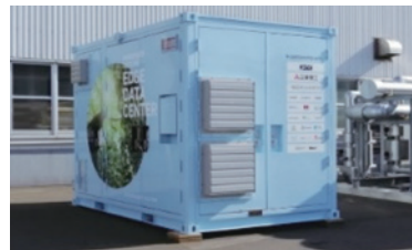
コンテナ型データセンタ
