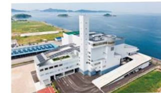
三菱重工環境・化学エンジニアリング(株) ごみ焼却発電施設
