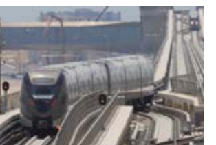
2019 世界最大級 カタールで全自動無人運転都市鉄道「ドーハメトロ」が運行開始(単線地下鉄・都市鉄道)
