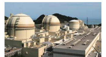
三菱重工(株) 加圧水型原子力発電プラント / 関西電力(株)大飯発電所
