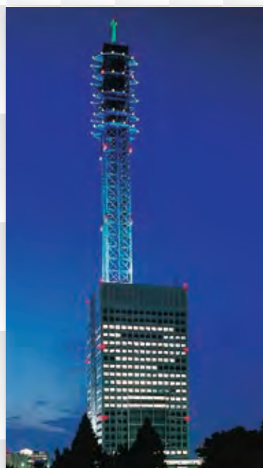
横浜メディアタワー (横浜) [収容台数:165台]
