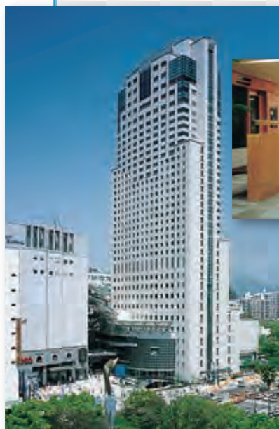
NTTクレド基町ビル (広島) [収容台数:536台]
