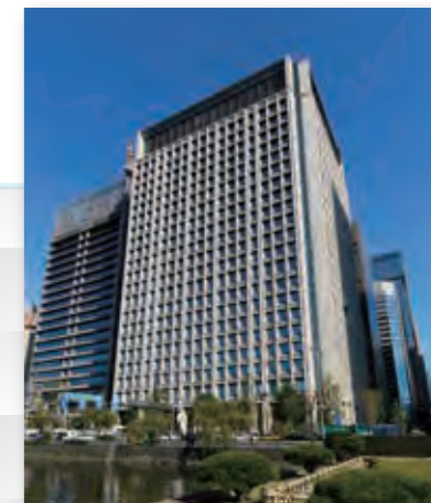
大手門タワー・JXビル (千代田区) [収容台数:165台]
