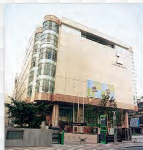
NTT-Tビル (きらめき通り駐車場) (福岡) [収容台数:385台]
