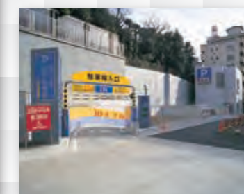
麻布十番公共地下駐車場 (港区) [収容台数:325台]
