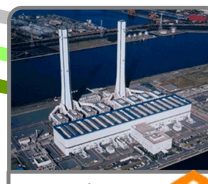
発電プラント
