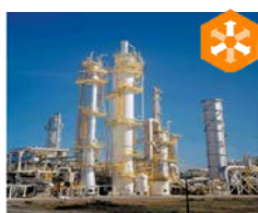
CO 2 回収装置
