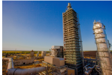
CO2 recovery plant (USA)
