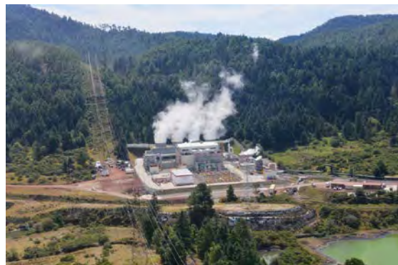
Los Azufres No.3 plant (Mexico)
