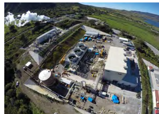
Domo de San Pedro plant (Mexico)
