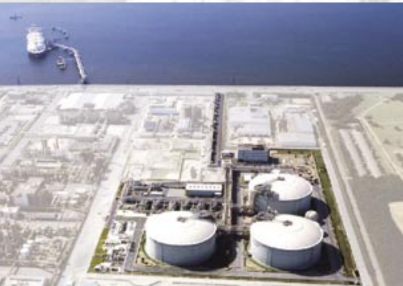
LNG Above-ground Storage Tank
